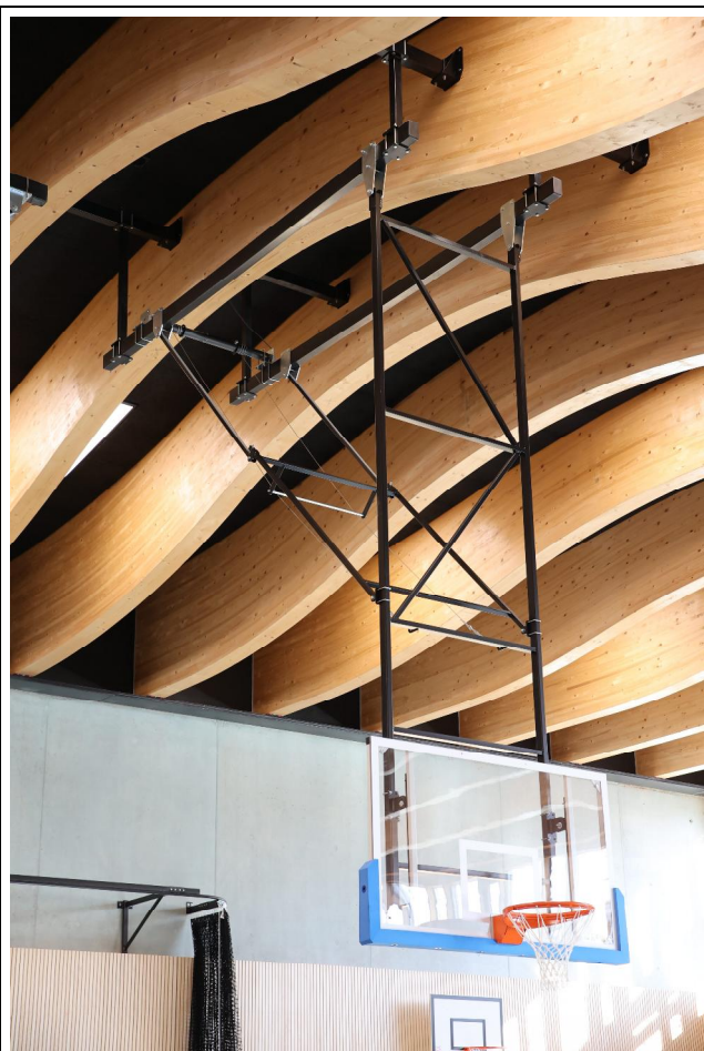
Basketball-Deckengerüst vorwärts oder rückwärts zur Decke hochziehbar (Art.-Nr. 36600+36602)
